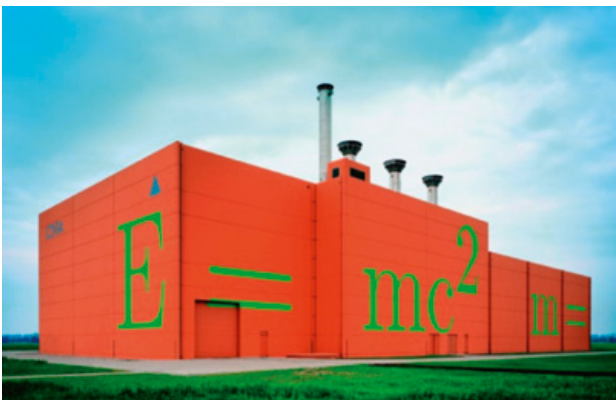
Figuur D.3 Het HABOG – de buitenkant.
