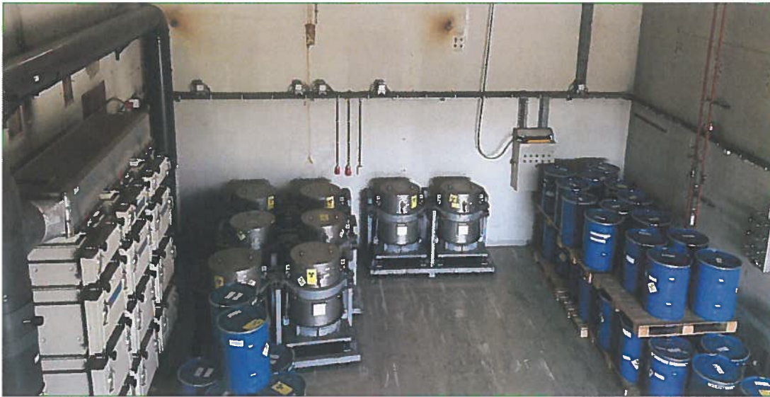
Figuur 4 Binnenzijde van de STEK-hal
