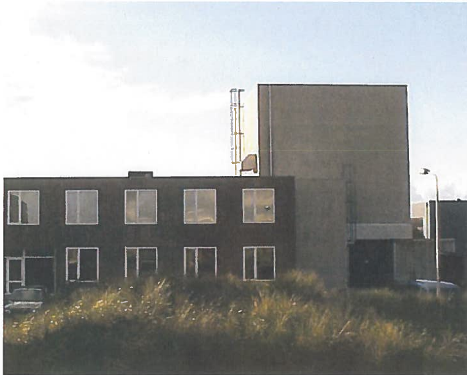
Figuur 2 Gevelzicht STEK-hal (rechts) en overig deel van het Fermi-gebouw (links)
