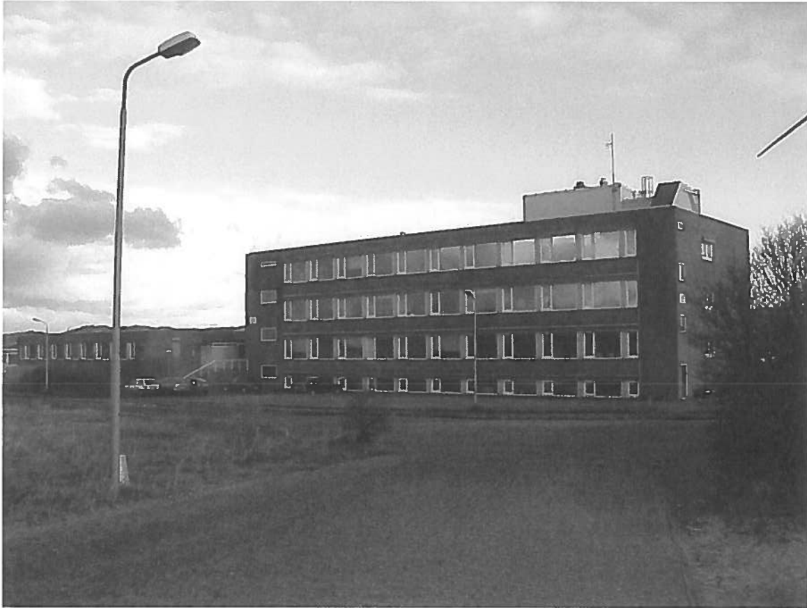
figuur 2 Gevelaanzicht GBD-gebouw
