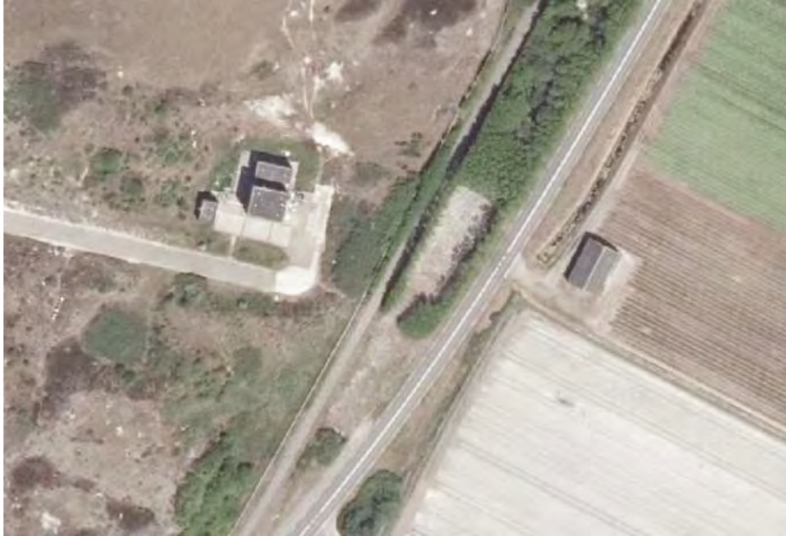
Afbeelding 8: Luchtfoto van de locatie waar de tijdelijke toegangsweg uitkomt op de N502. Bron: https://maps.noord-holland.nl/nh_door_de_tijd/ , geraadpleegd op 13-01-2021.
